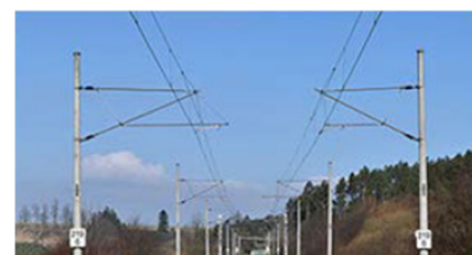
5. Обнаружение и инспекция воздушных линий
